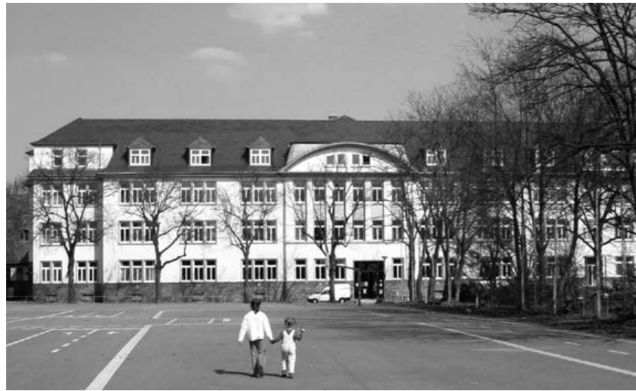
neu saniertes Bürgerhaus, 2004
