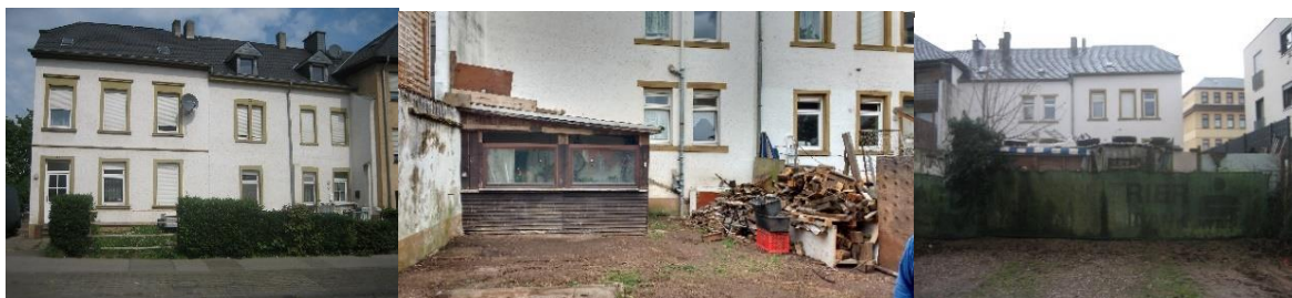
Abbruch der Häuser Thyrsusstr. 28/30
