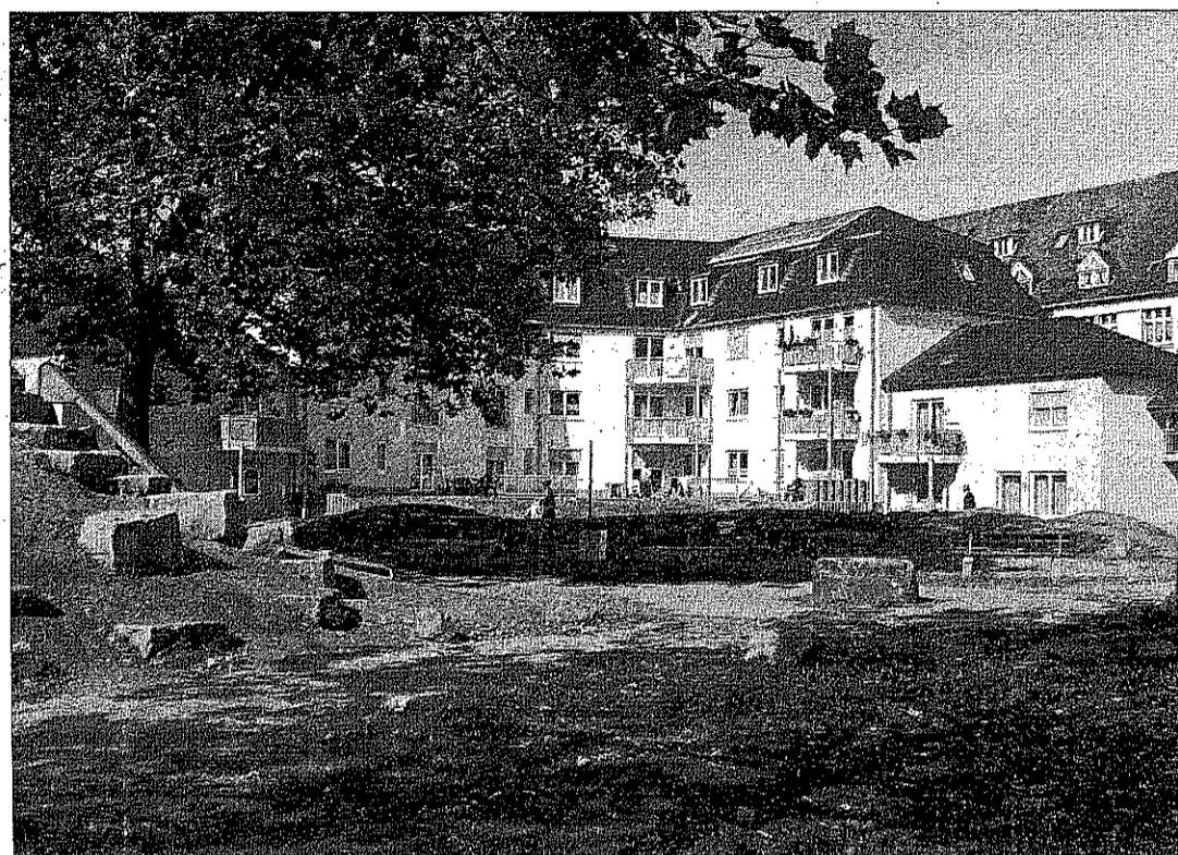
Durch genossenschaftliche Selbsthilfe haben die Häuser der Genossenschaft am Beutelweg eine große Aufwertung erfahren
