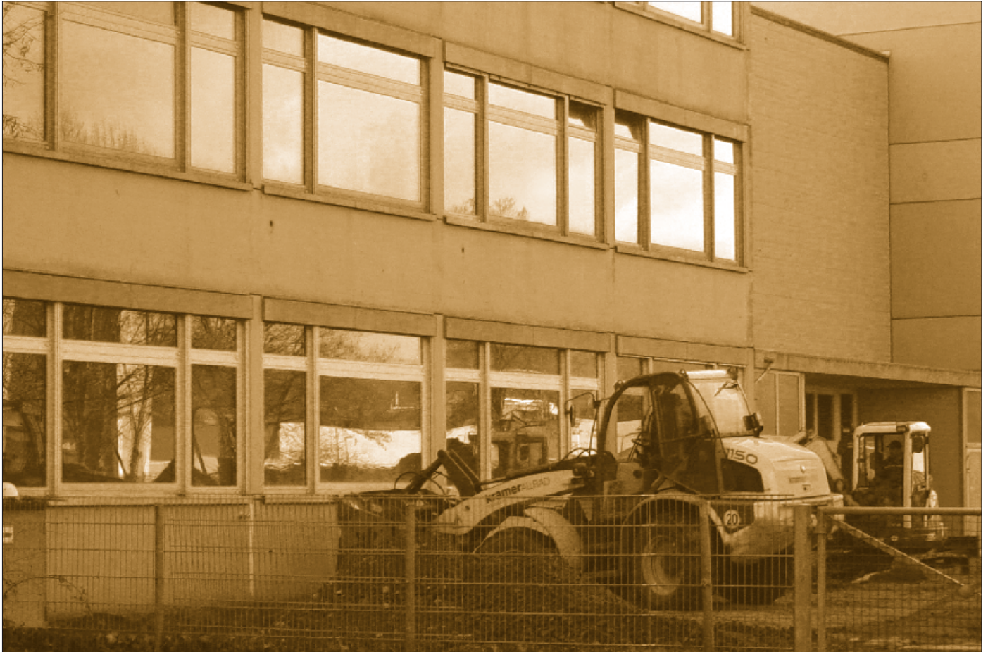
Das Schulgebäude Thyrusstraße wird saniert, Foto: Maria Ohlig
