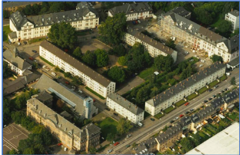
Erste Schritte der Sanierung des maroden Wohnungsbestands im Viertel
