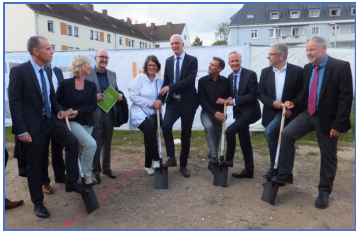
„Neues Wohnen Thyrsusstraße“ (Wohnen im Quartier) Spatenstich für das dritte und größte Projekt
